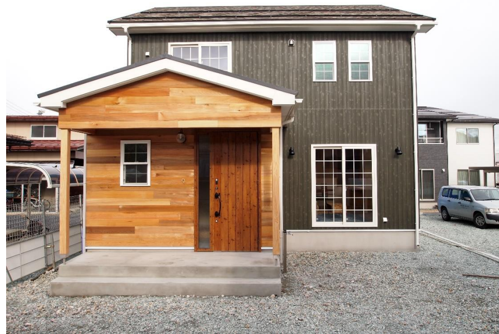
全体は落ち着いたグリーンに、玄関部分はアクセントでレッドシダーをふんだんに張ったオリジナル感溢れるカッコ良い外観です。
